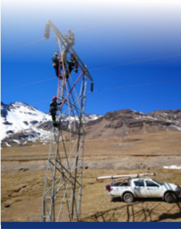
El mantenimiento de las líneas de transmisión en 69 kV considera la inspección preliminar y el posterior mantenimiento en línea energizada (hot line) en un 80% de las líneas y el resto mediante cortes de energía programados, logrando cumplir con el cronograma establecido.
